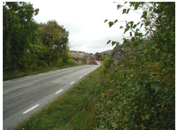
Väg 889, där siktsprängning erfordras.
